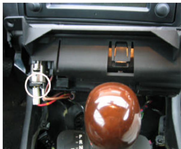
Bild 10: Kabel vom Zigarettenanzünder
